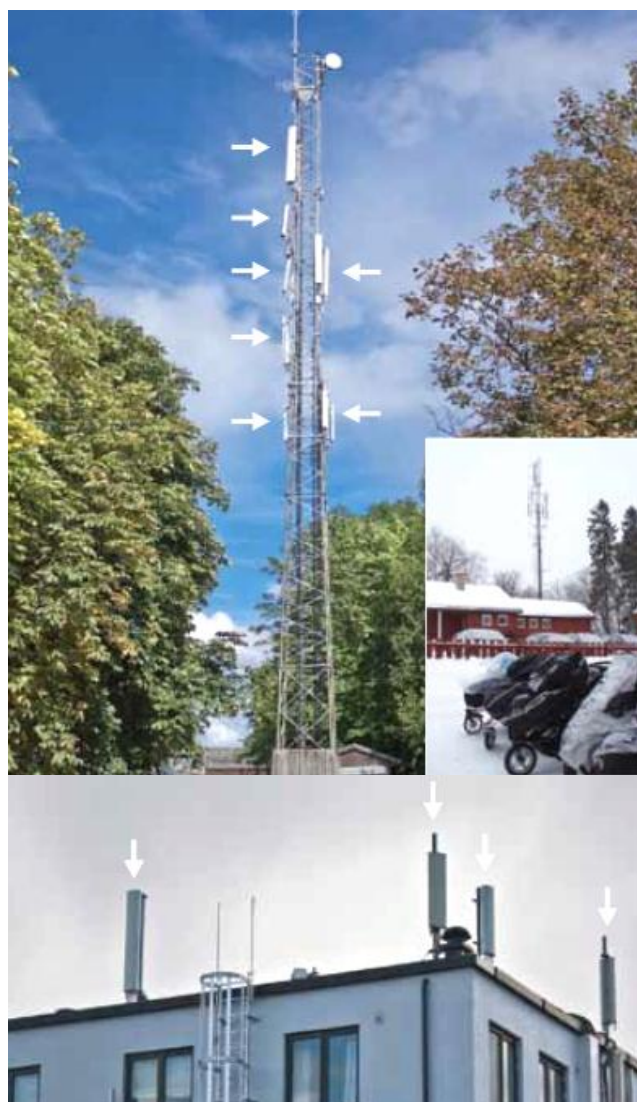
Pilene markerer mobilmastesendere på mobilmast og hustag.
